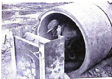
Bild 1. Hantverket är tungt och arbetsplatsen trång, när bergbormaskinen åter sig genom skyddsrumsbetongen.
